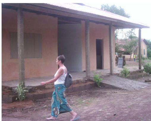
(Photo du bâtiment fin des travaux de réhabilitation)
