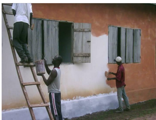
(Photo du bâtiment lors des travaux de badigeon)
