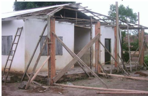
(Photo du bâtiment lors des travaux réhabilitation)
